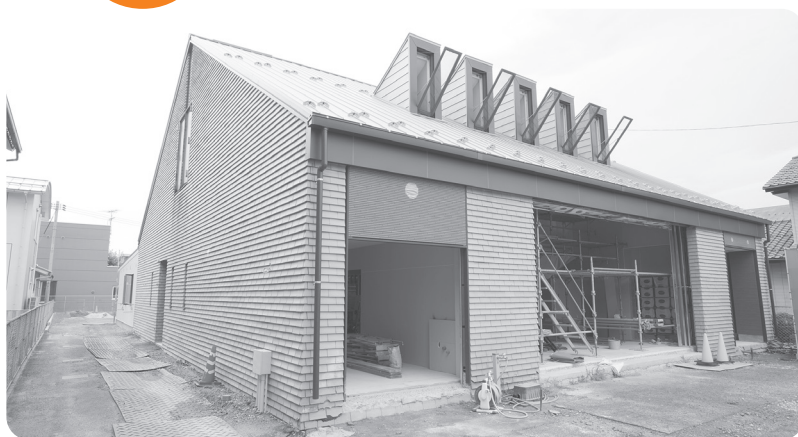
斐川生協病院西側の旧大社信用金庫の建物を改築中
